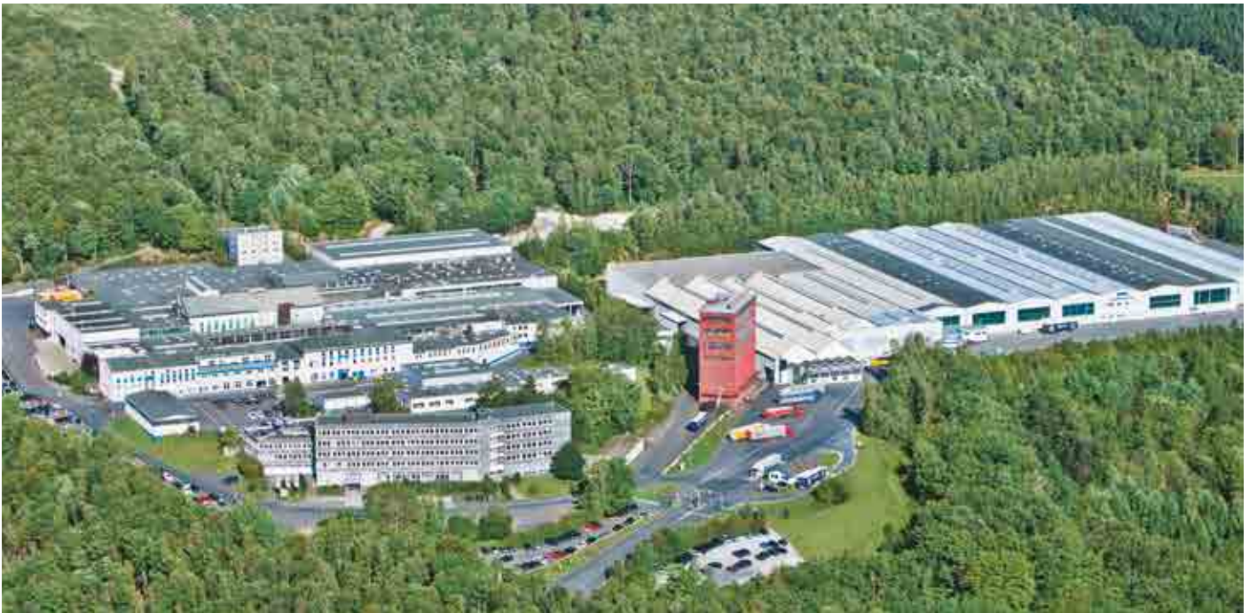
Hauptverwaltung und Werk Neunkirchen (D)
