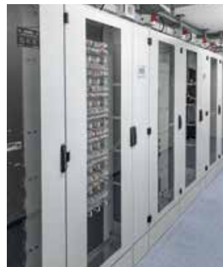
IS-1 Vierschrank-System mit redundanten, in der Reihe angebrachten SideCoolern CW.
