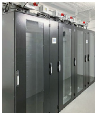
Vierschrank-System IS-1 Edge Row Typ 4 mit zwei in der Reihe angebrachten SideCoolern von SCHÄFER IT-Systems.
